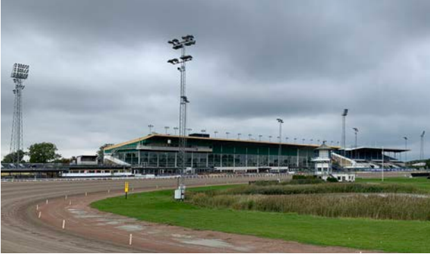
Travbanans kurvatur kan bilda utgångspunkt för ny bebyggelse.
