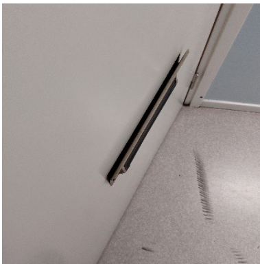
Figur 1. Otät lägenhetsdörr genom brevinkast.
