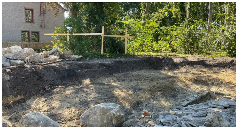
Bild 17. Avhjälpandeåtgärder 2023 inom mötesplats "Stationshotellet" (delområde E), schaktdjup 1 meter.
